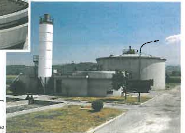
5) Digestione anaerobica fanghi
