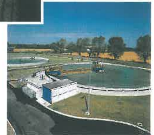
3) Sedimentazione finale in bacino circolare con ponte mobile aspirante
